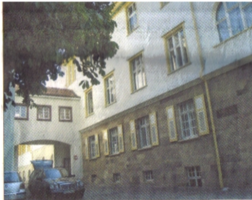
Den Seitenflügel (rechts) der ehemaligen Mutter-Kind-Kurklinik Haus Hohenbaden will das Casa Vitale für Senioren-WGs nutzen. BILD: HANS-JÜRGEN EISENMANN
